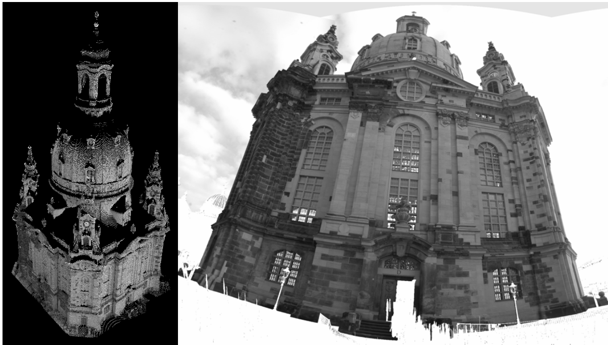
Abb. 15: 3D terrestrische Laser Erfassung und RGB-Bilddatentexturierung.
